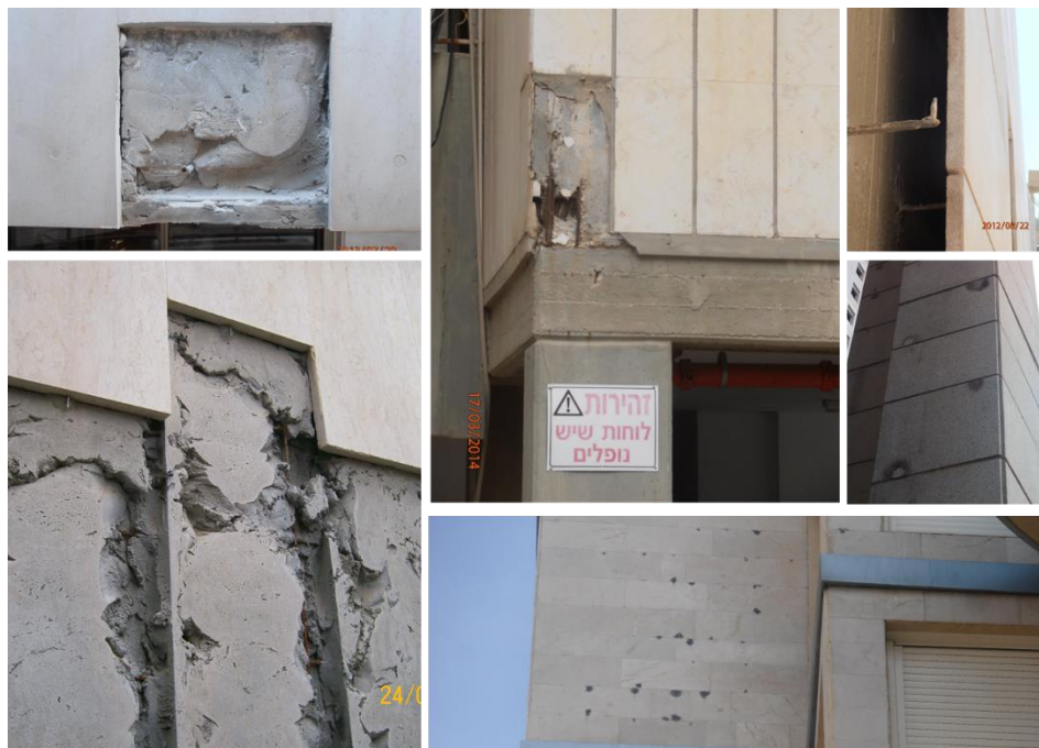
דוגמאות לליקויי חיפויי אבן, בבניה חדשה ולאחר שיקומים קודמים שלא צלחו
